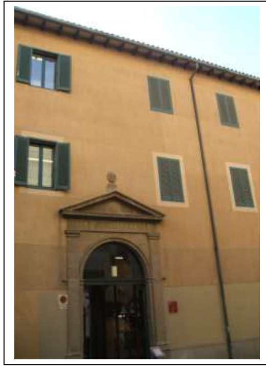
Edifici, restaurat, de l'antic Col·legi Episcopal, al carrer Ntra. Sra. de Montalegre.
