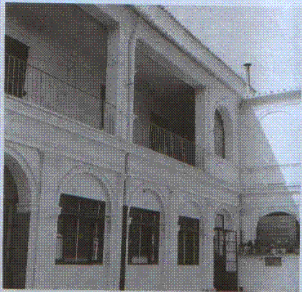
Llotgeta interior de la Casa dels Orfes, fundació de Climent.
